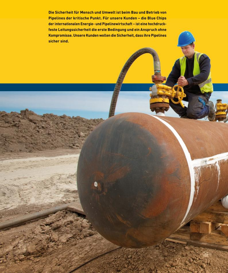
Die zerstörungsfreie Prüfung und die verlässliche Feststellung einer garantierten Druckfestigkeit ist das Sicherheitszertifikat für den Rohrleitungsbau. Die dazu eingesetzten Dichtheits- und Festigkeitsprüfungen mit den Medien Luft, Gas und Wasser sind unsere wichtigsten Aufgaben in der Vor-Inbetriebnahme von Pipelines.
